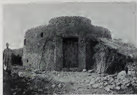
Abb. 22. Neubau ohne Dach.
